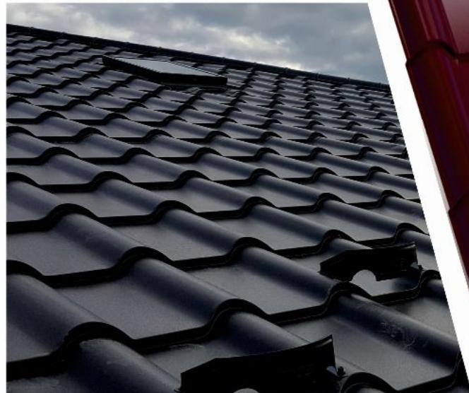
Suprapunerile optimale pentru rezistență sporită a învelitorii și etanșeizare a acoperișului
