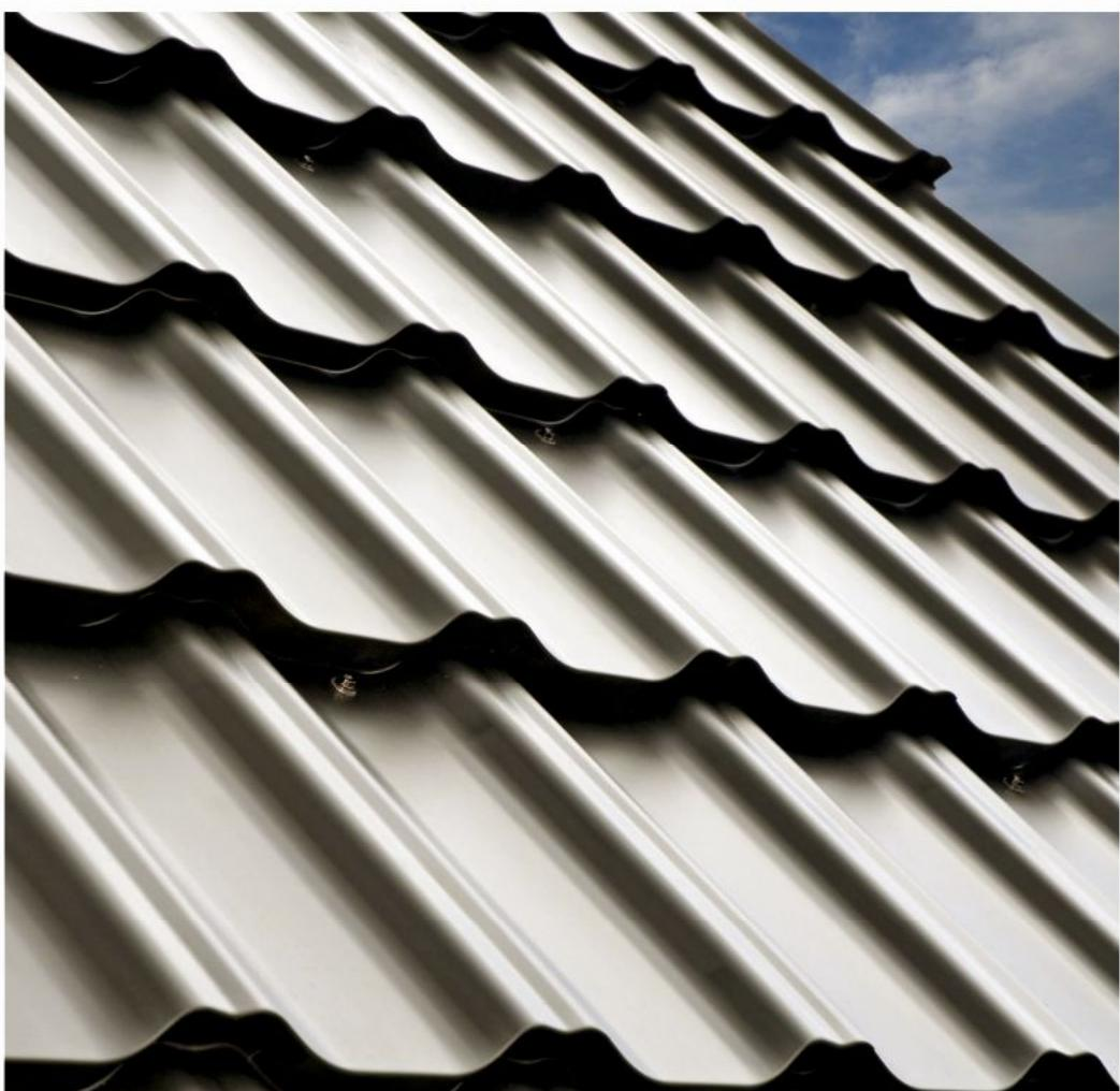
Cuta de tip "Z" obține funcția de încuietare la montarea colilor eliminând necesitatea de îmbinare adițională a colilor cu șuruburi pe suprafața cutelor:
